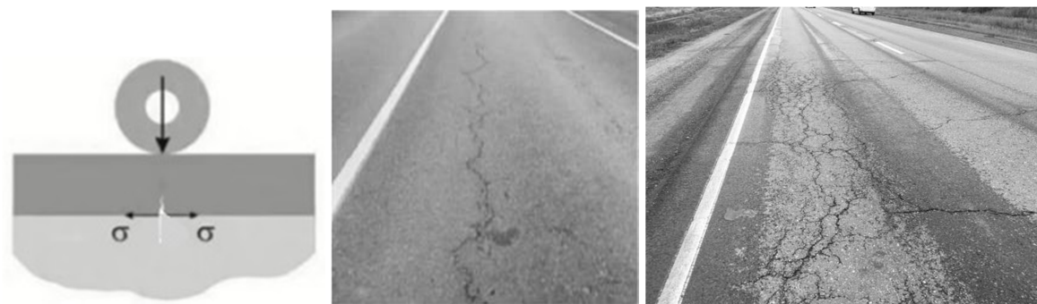
Рис. 1. Образование усталостных трещин на асфальтобетонном покрытии автомобильных дорог
