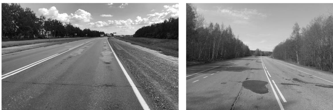
Рис. 6. Отраженные трещины, повторяющие трещины в нижележащих слоях
