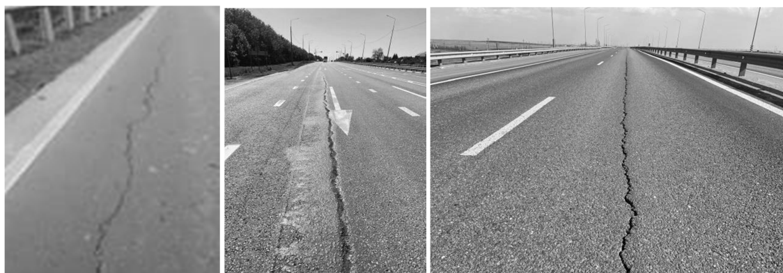
Рис. 3. Продольные трещины вдоль границы уширения конструкции дорожной одежды
