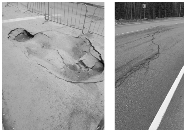
Рис. 4. Трещины, возникающие на асфальтобетонном покрытии в результате недопустимых деформаций грунта земляного полотна
