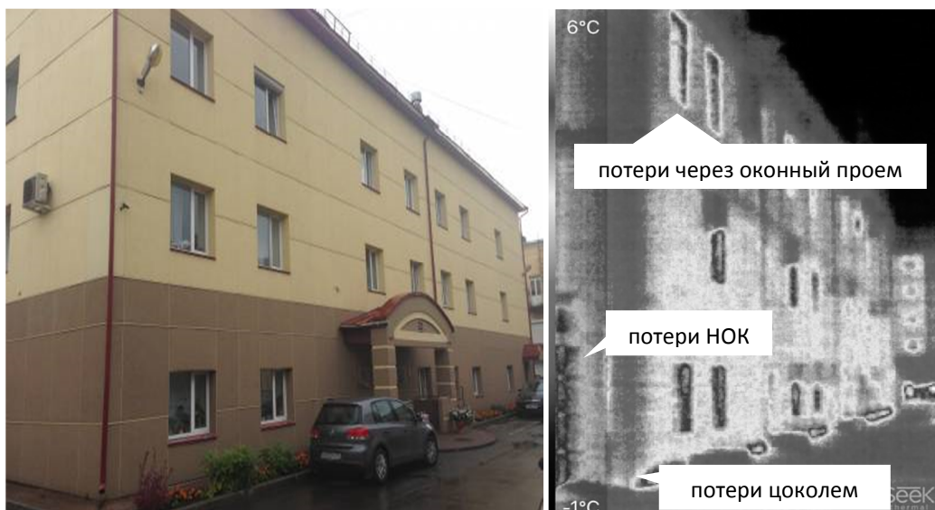
Рис. 2. Фотография наружной стены здания и ее термограмма
