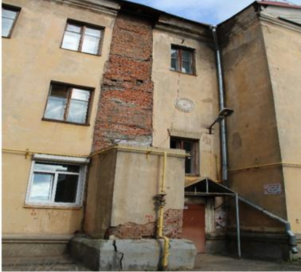
Рис. 4. Дефекты кирпичных стен
