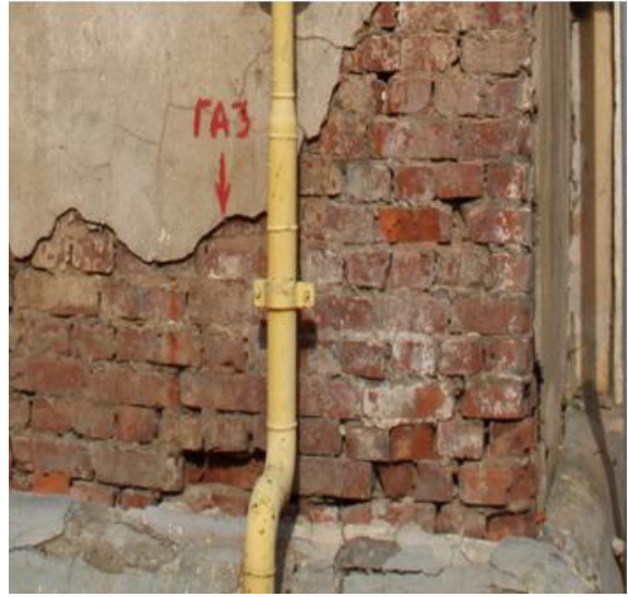
Рис. 4. Дефекты кирпичных стен
