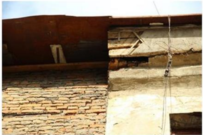
Рис. 5. Дефекты карнизной части стены
