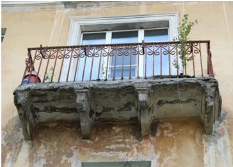
Рис. 6. Дефекты балконов и трещины в стене
