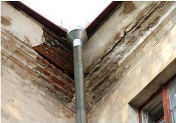
Рис. 5. Дефекты карнизной части стены
