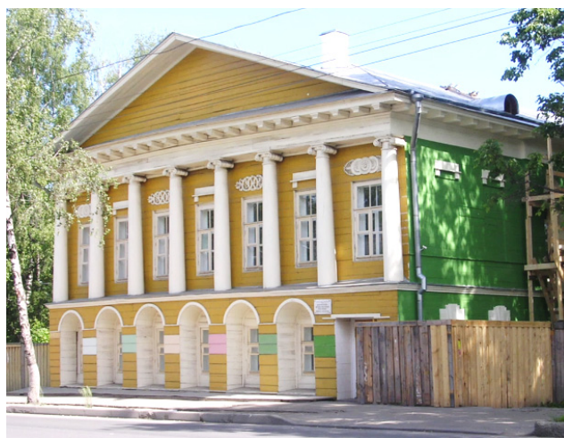
Рис. 7. Реставрационные работы на доме Левашовых. Фото 2005 г.
