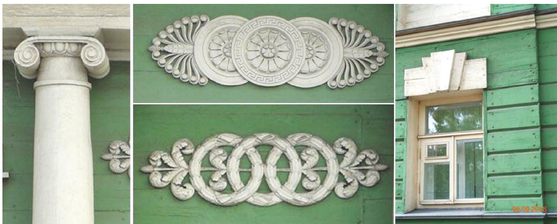
Рис. 5. Архитектурные детали фасадов
