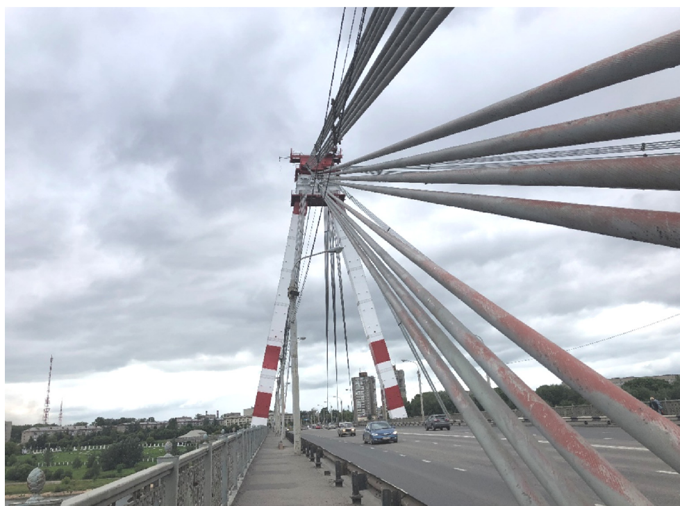
Рис. 5. Октябрьский мост, июль 2019 г.
