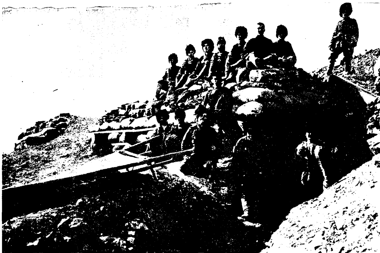
Входъ подъ блиндажи лѣваго фланга Высокой горы. Блиндажи эти на тыловой сторонѣ горы. На блиндажѣ сидятъ и около стоятъ стрѣлки 2-й роты 5 Вост. Сиб. стр. полка.
