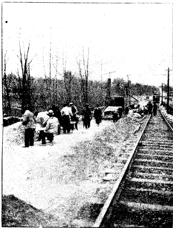
Рис. 3. Заготовка бетона для основанія.
