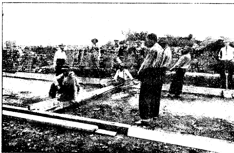
Рис. 1. Отдѣлка земляного полотна.
