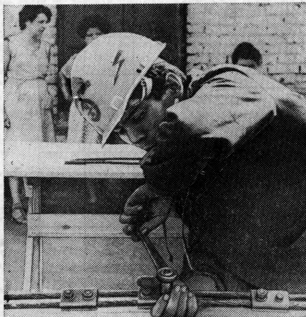
Рис. 2. Электромонтер К. А. Гартунг сращивает концы троса
