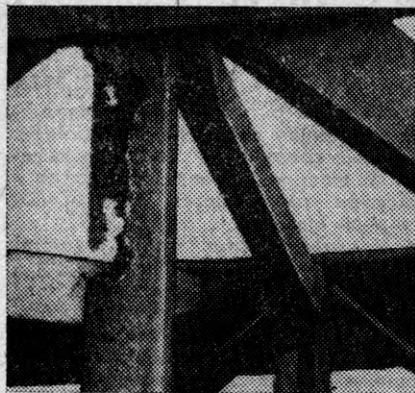
Сквозная коррозия стоек в ригелях
