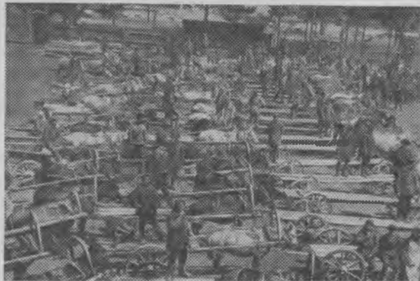
Так начиналось строительство
