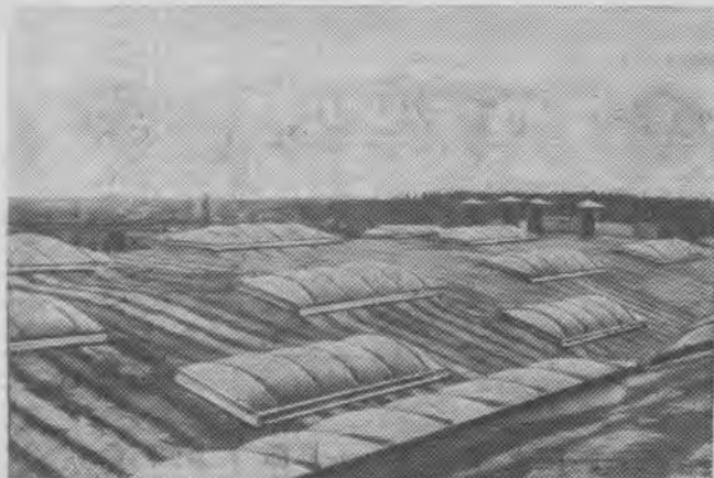
Рис. 1. Депо Орехово Московской дороги. Здесь над производственными помещениями установлены зенитные фонари из органического стекла. Они намного улучшили освещение цехов
