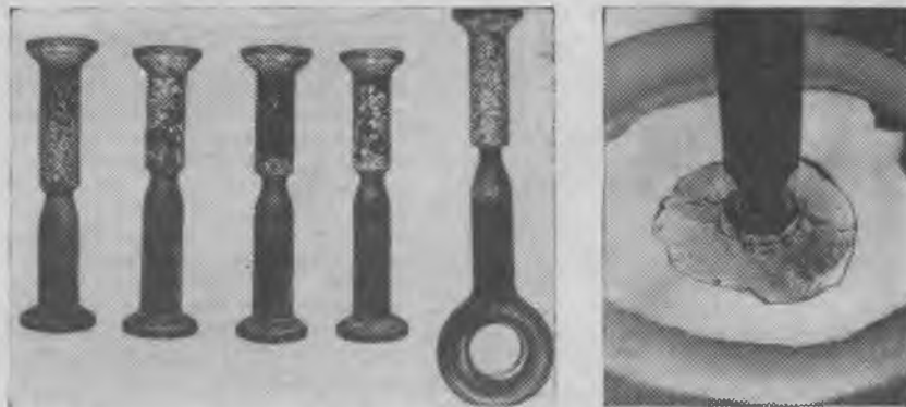
Рис. 1. Коррозионные повреждения стержней изоляторов: а — образцы стержней с коррозией; б — стержень после удаления продуктов коррозии в месте выхода из цементной заделки
