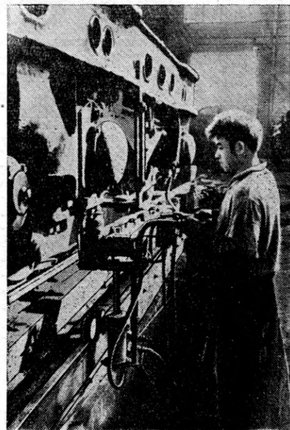
Позиция разборки (сборки) тележек оборудована электрогайковертами ударного действия, гидродомкратами и другими механизмами
