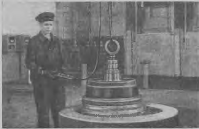
Ударник коммунистического труда А. С. Мединцев за пропиткой якоря тягового двигателя НБ-406
