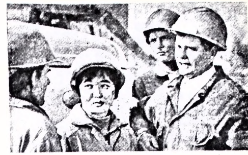
КИРГИЗСКИЙ ССР. В селе Кыз-Молок совхоза «Ак-Суу» Маскоровского района недавно выросла одна двухэтажных котельей. В них справили носелье семьи рабочих хозяйства. Строители — коллектив комплексной бригады, которую в Беловодской межхозяйственной передельной механизированной колонне треста «Чувагропромстрой» уже 15 лет возглавляет Петр Антонович Борсенко, лауреат Государственной премии СССР 1987 года.
