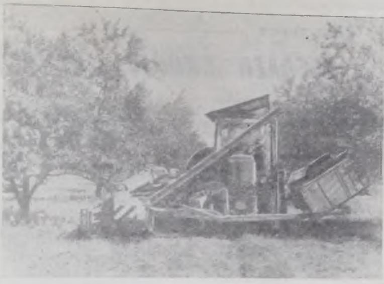
Народная Республика Болгария в рамках СЭВ специализируется на производстве машин для посадки и переработки овощей, уборки фруктов, обработки виноградарства. НА СНИМКЕ: новая машина «Балкан-3М», созданная в экспериментальной мастерской Института фруктоводства в Пловдиве. Она предназначена для сбора урожая фруктов. Фото ТАСС.
