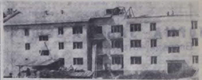
НА СНИМКЕ: строится 36-квартирный жилой дом по тресту Тотыма. Строят СМУ треста «Вологдагражданинстрой». Еще не закончена кладка стен, нет крыши на одной части здания, а на другой — оконные блоки застеклены, ведутся отделочные работы.
