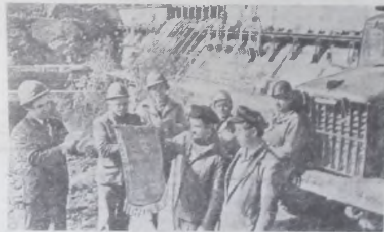
АМУРСКАЯ ОБЛАСТЬ. Около 10 миллиардов киловатт-часов энергии дала Зейская ГЭС народному хозяйству Дальнего Востока. НА СНИМКЕ: заместитель председателя объединенного стройкома «Зейгэстроя» Б. П. Акишбаров (слева) вручает переходящий вымпел водителю «КрАЗа» коммунисту В. Ф. Мачекину — одному из лучших на стройке.
