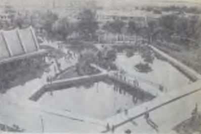
УКРАИНИСКАЯ ССР. Миргород — популярный город республики. Отличная лечебная база, целебные минеральные источники, пруды и парки привлекают сюда тысячи трудящихся. Курорт расширяется. Здесь выросли новые спальные корпуса, столовая, водогрейно-лечебница, реконструирована поликлиника. В Миргороде ежегодно отдыхают и лечатся 50 тысяч человек. Фото ТАСС
