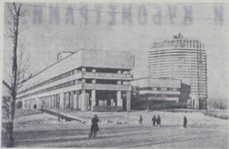
МОСКВА. На юге столицы трест «Мосстрой-7» завершает сооружение гигантского комплекса Всесоюзного онкологического научного центра, часть которого уже действует. Закончен монтаж наружных облицо-
