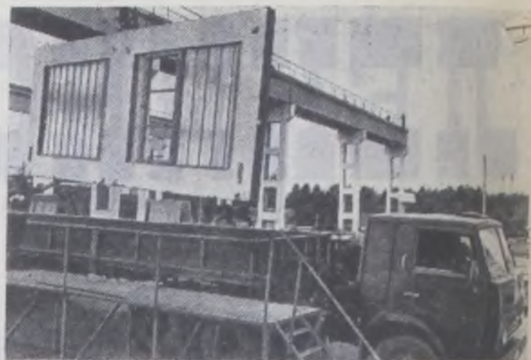
МОСКОВСКАЯ ОБЛАСТЬ. На сельских стройках Подмосковья хорошо знают продукцию Клинского экспериментального комбината...
