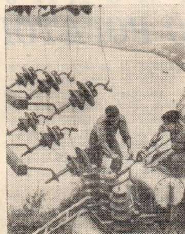
ДРВ. Бригада электриков в провинции Нгеан восстанавливает разрушенную американскими бомбами линию электропередачи.
