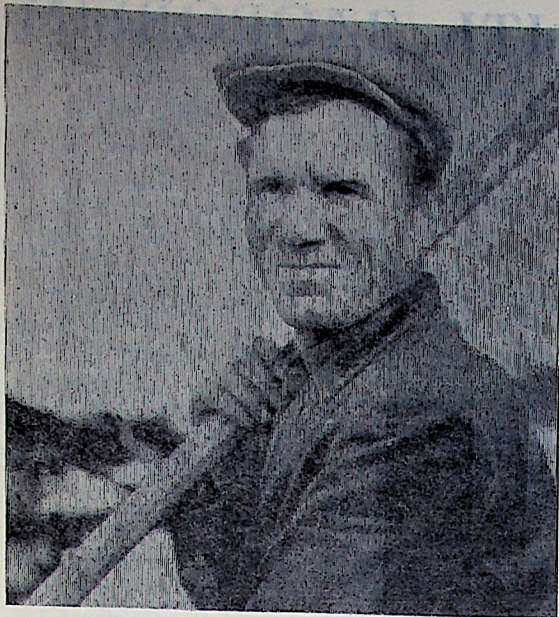
НА СНИМКЕ: Владимир Поликарпович Бугаенко. Он возглавляет бригаду плотников Пятовского объединенного рейда. Коллектив бригады Бугаенко, ежедневно перекрывая нормы, плотит за смену по 600—700 кубометров леса.
