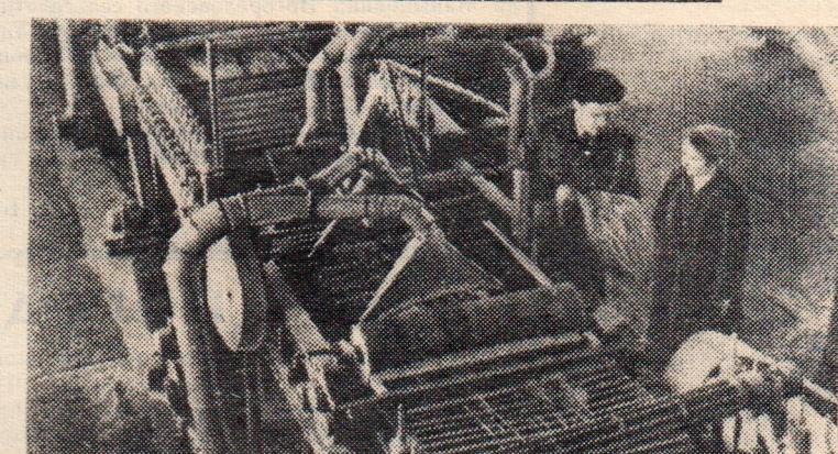
В Псковской экспериментальной лаборатории сдана в эксплуатацию новая автоматическая линия для переработки соломки льна (на снимке). Благодаря этой линии отпадают операции сортировки длинных и коротких стеблей, увеличивается сбор волокна.
