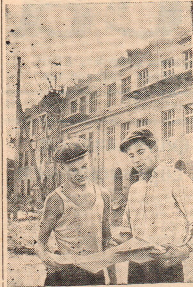
В городе Вологде на улице Панинцев идет строительство нового четырехэтажного здания Педагогического института им. В. М. Молотова.
