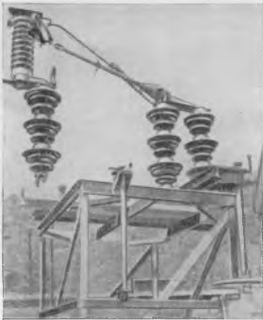
Рис. 2. Однополюсный выключатель нагрузки 115 кВ в процессе отключения.
