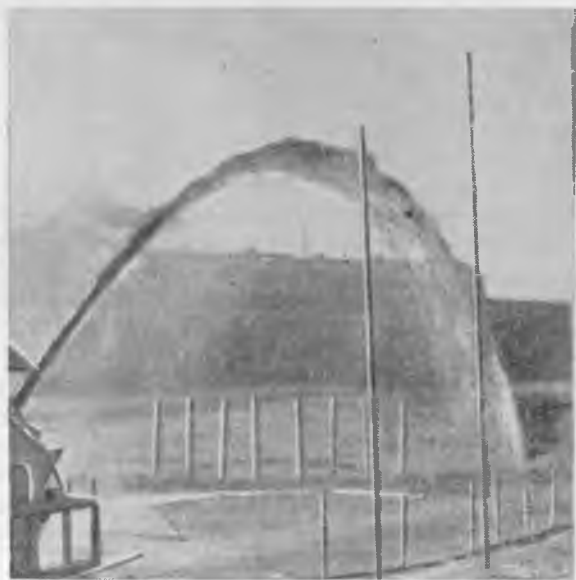
Рис. 5. Прицельное метание грунта неразрывной струей.
