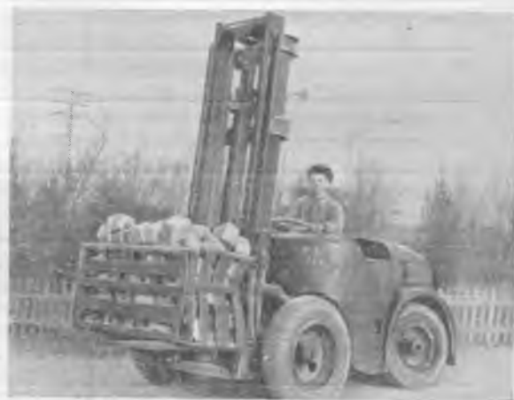
Рис. 2. Транспортировка автопогрузчиком контейнера с фасонным кирпичом.
