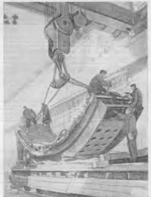
Рис. 8. Четвертина статора генератора в машинном зале до установки в кратер турбоагрегата.
