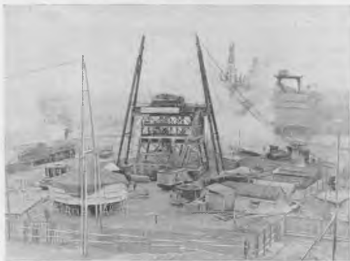
Рис. 1. Внешняя монтажная площадка.
