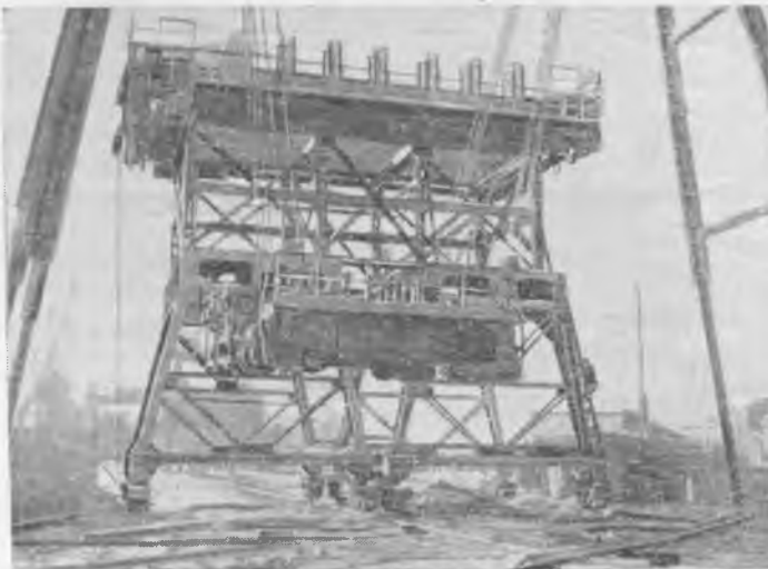
Рис. 7. Подъем тележки крана на подвижную эстакаду.
