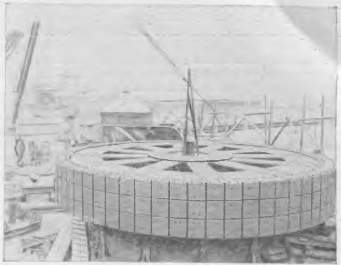
Рис. 5. Собранный обод ротора генератора на внешней монтажной площадке.
