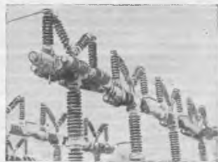
Рис. 2. Верхняя часть одной фазы воздушного выключателя 230 кВ.
