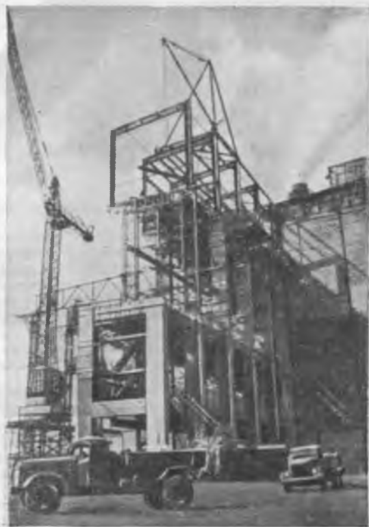
Рис. 2. Монтаж деррик-краном металлоконструкций дымососной.
