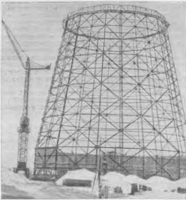
Рис. 2. Монтаж каркаса и обшивки градирни при помощи крана СБК-1.
