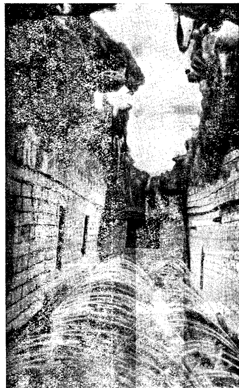
Рис. 8. Нижняя часть топки со стекающим в шлаковый комод шлаком (паропроизводительность агрегата равна 0,8 D_n ).
