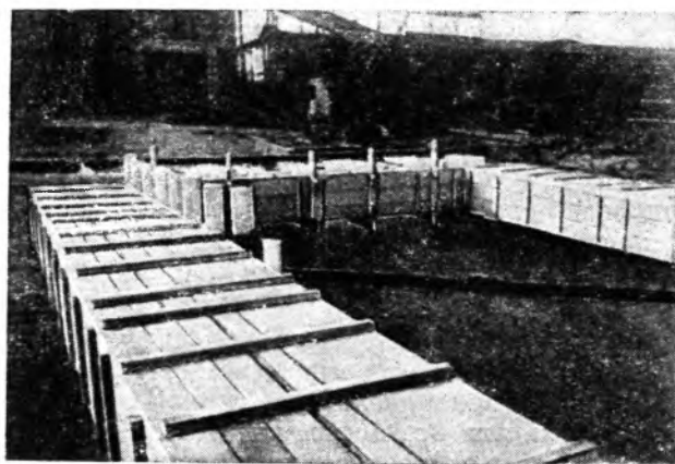
Рис. 12. Предварительная навеска опалубки на каркас рамы.
