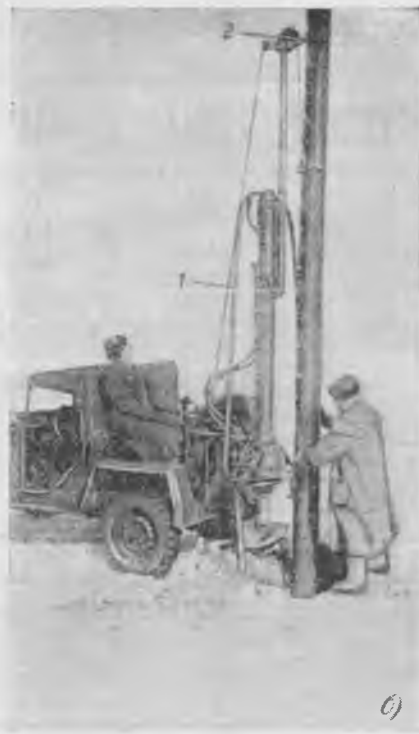
Рис. 2. Бурение ямы и установка столба бурильно-крановой машиной БКГМ-АН. а—машина в момент разброса грунта; б—установка столба в пробуренной яме при помощи кранового устройства машины.
