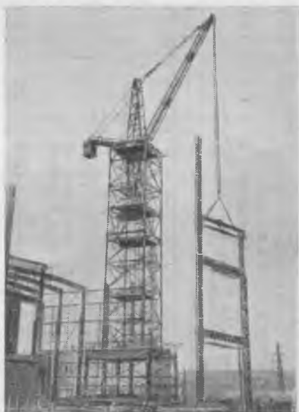
Рис. 3. Подъем блока колонн деаэраторного отделения.
