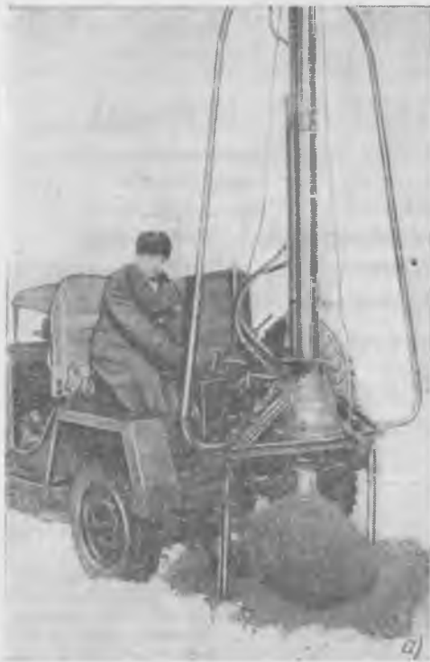
Рис. 2. Бурение ямы и установка столба бурильно-крановой машиной БКГМ-АН. а—машина в момент разброса грунта; б—установка столба в пробуренной яме при помощи кранового устройства машины.
