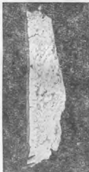
Рис. 1. Образец (в изломе) шамотной обмуровки топки котла. Слева видна покрывающая обмуровку шлаковая корка.
