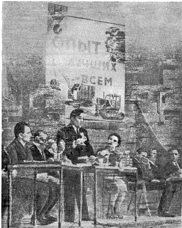
На снимке: вечер механизаторов стройки.
