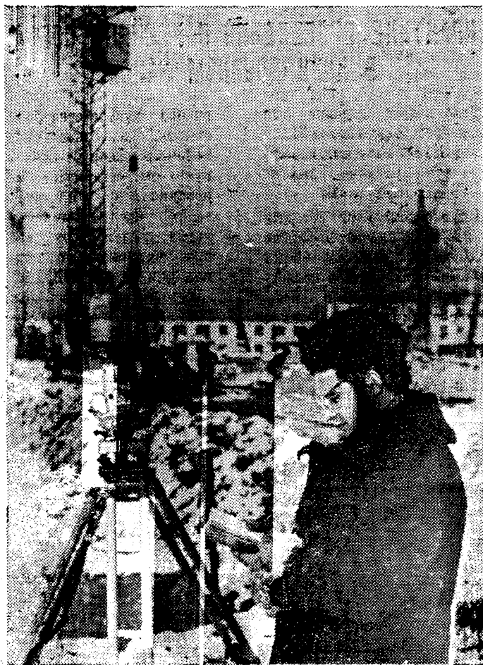
На снимке: старший прораб А. М. Стегайлов ведет разбивку фундамента под крупнопанельный жилой дом. --
