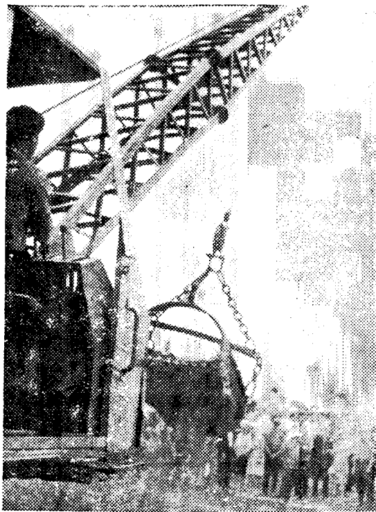
На снимке: вынут первый ковш земли.
