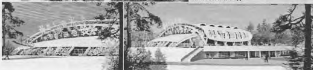
Рис. 7. Строительство Ледового дворца в г. Великом Устюге
