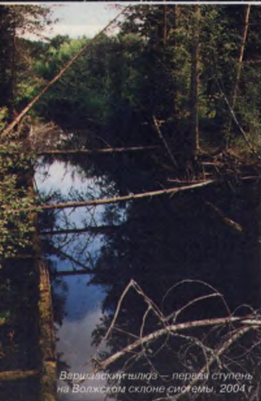
Нижняя голова Варшавского шлюза
