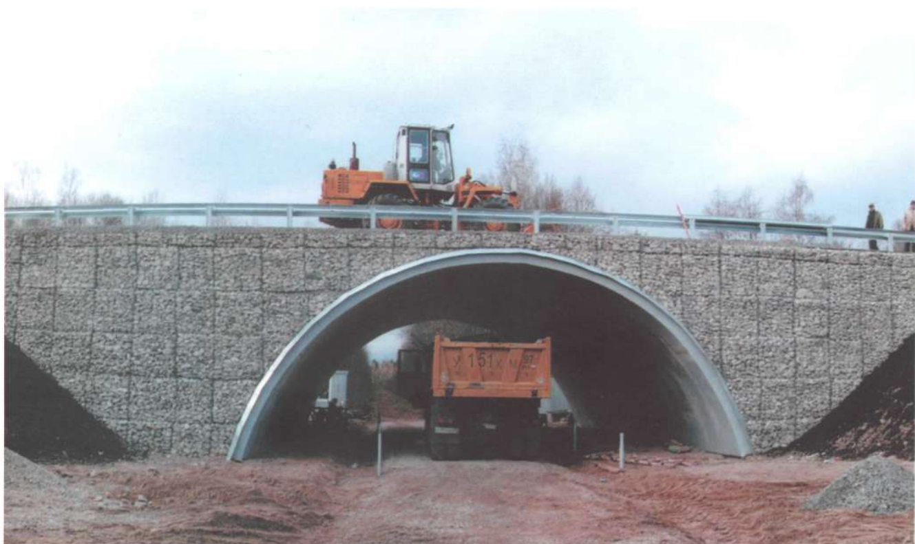
Замена путепровода на железобетонную трубу с арочным перекрытием на 156 км автодороги Вологда - Новая Ладога. 2005 год.
