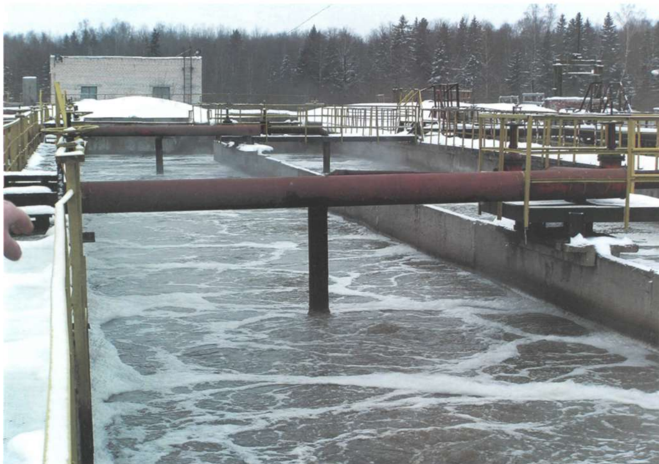
ООСК г. Сокола, реконструкция системы аэрации.
