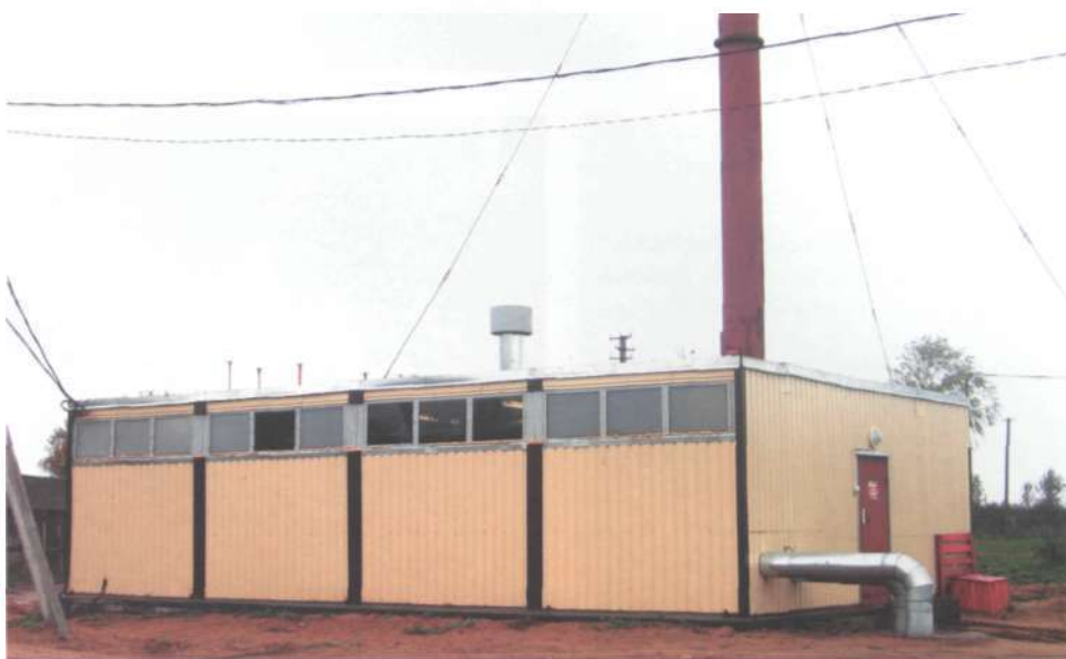
Запуск блочной котельной на природном газе марки «Факел» мощностью 3,6 Гкал/час в поселке Лесково Вологодского района. 12 марта 2004 года.
