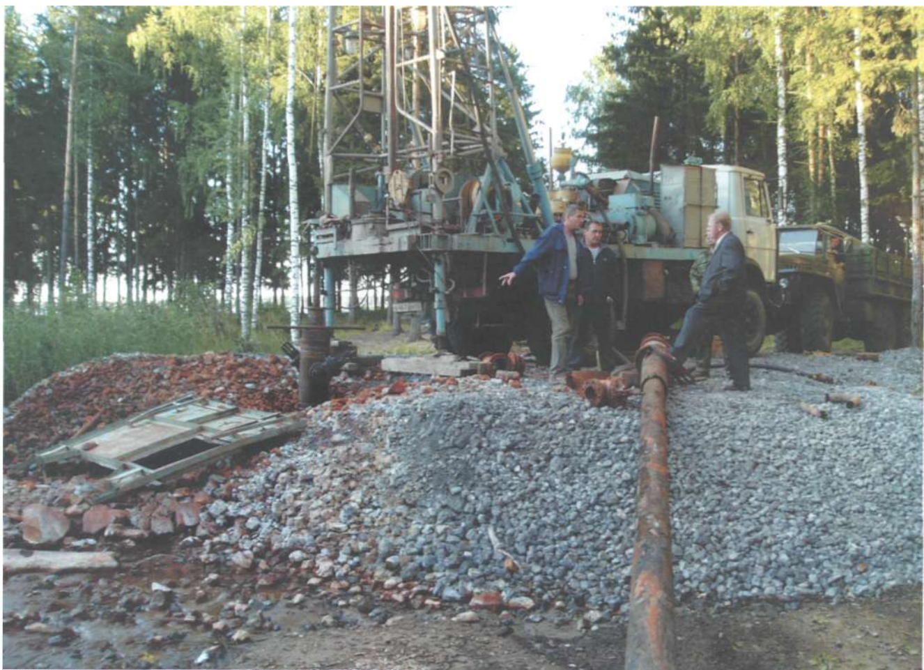
Работы по ликвидационному тампонажу скважины 6М в п.Суда Череповецкого района.
