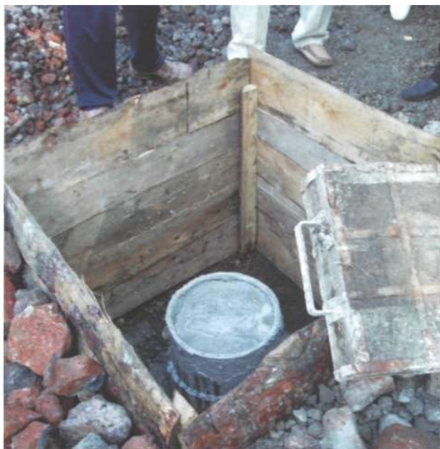
Фонтанирующая скважина 6М в п.Суда Череповецкого района (дебит 210 л/сек., давление 4 атм.) (на фото слева); в 2006 г. скважина затампонирована (на фото вверху).
