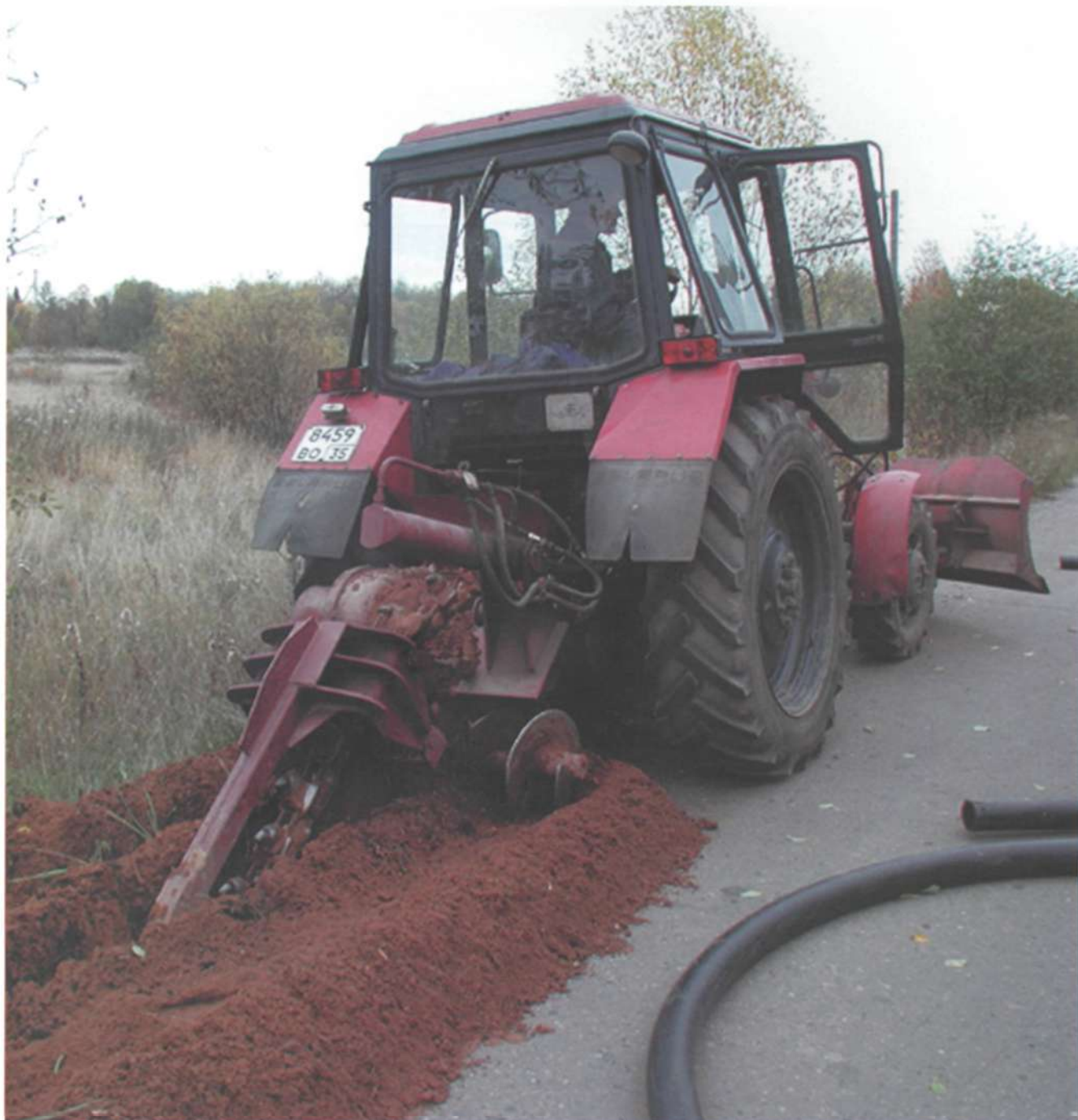
Рытье траншеи для укладки полиэтиленового газопровода.
