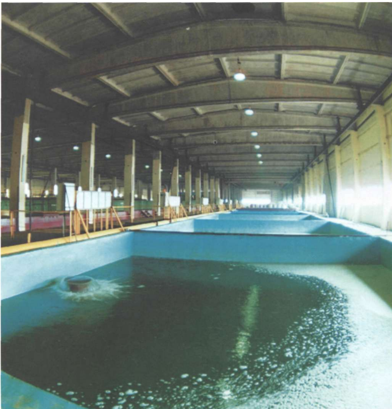
Водоочистная станция № 3 в Череповце с двухступенчатой технологической схемой очистки производительностью 115 тысяч кубометров в сутки сдана в эксплуатацию в 2001 году.
