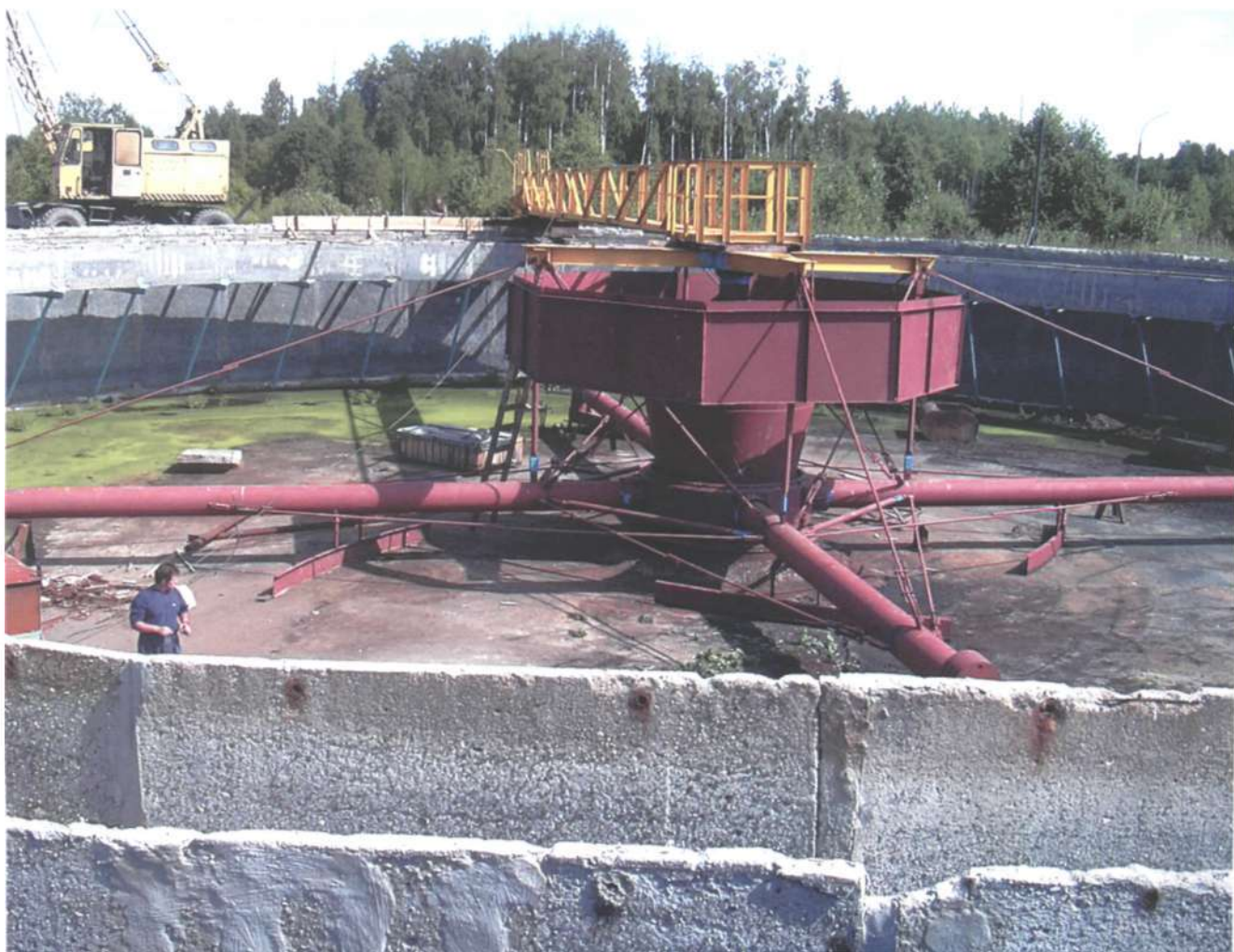
ООСК г. Сокола, монтаж илового насоса.
