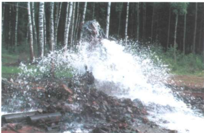
Фонтанирующая скважина 6М в п.Суда Череповецкого района (дебит 210 л/сек., давление 4 атм.) (на фото слева); в 2006 г. скважина затампонирована (на фото вверху).
