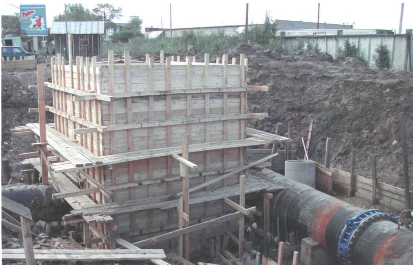
Строительство камеры с павильоном на магистральных водоводах для установки задвижек с электрическим приводом на улице Клубова (Вологда). 2004 год.
