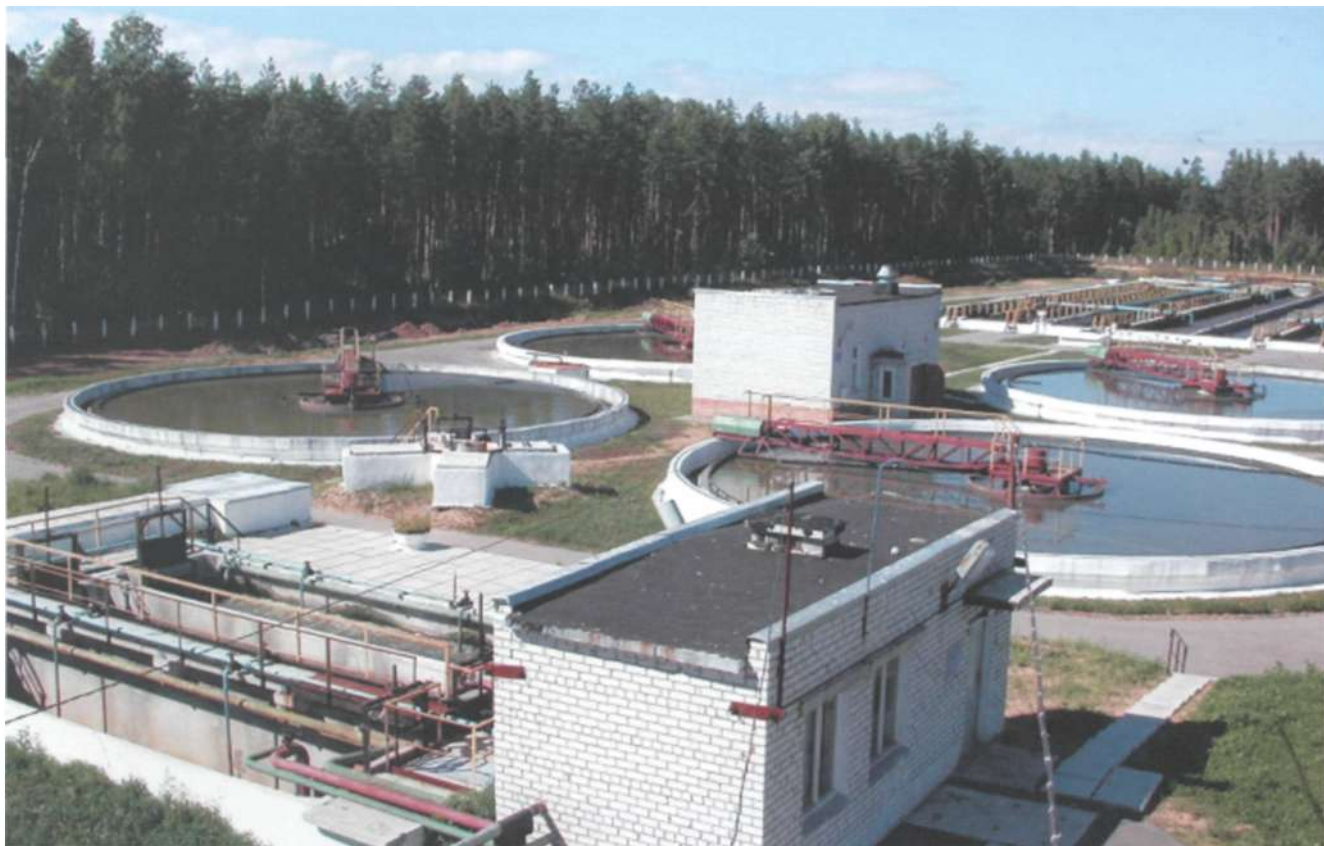
В 2003 году в Череповце была сдана в эксплуатацию вторая очередь левобережных очистных сооружений канализации производительностью 70 тысяч кубометров в сутки.
