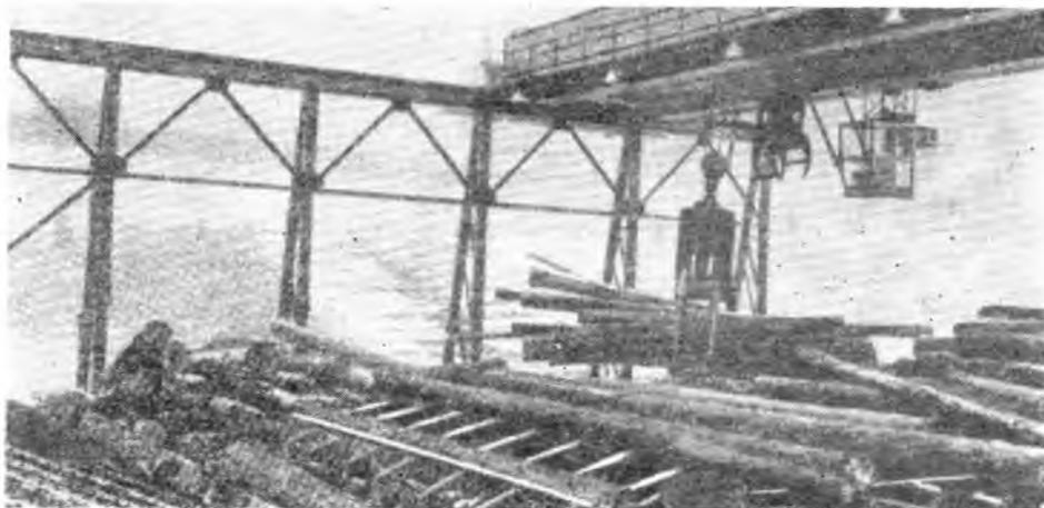
Мостовой кран фирмы «Эдерер» грузоподъемностью 35 т
