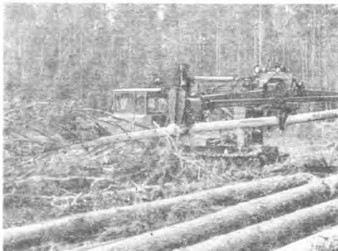
Обрезка сучьев машинами ЛН-30Б в Червенском леспромхозе
