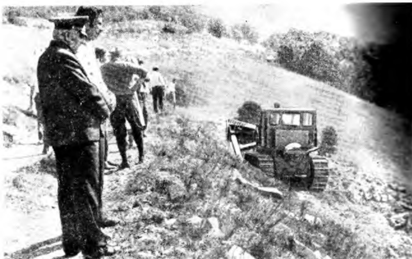
На участке подготовки террас в Новороссийском лесничестве
