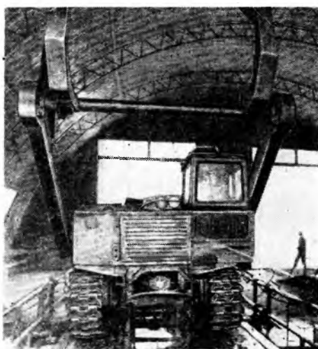
Участок механизированной мойки
