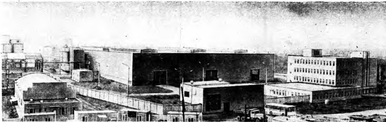
Дмитровский экспериментальный комбинат арболитовых конструкций и изделий (трест Лесдревмонтаж)
