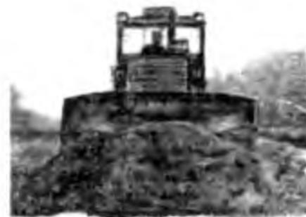
Рис. 1. Отсыпка грунта на основание из нетканого синтетического материала
