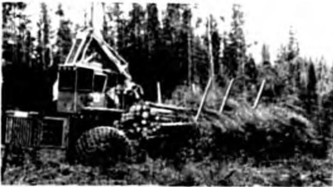
Рис. 4. Валочно-трелевочная машина
