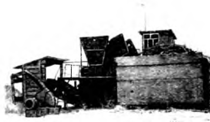
Рис. 2. Линия утилизации нижнескладских отходов в Березовском ЛПХ Алапаевсклеса
