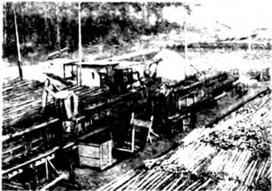
Рис. 2. Линия для раскряжки, окорки и сортировки мелкотоварного леса на нижнем складе
