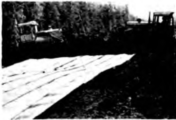
Рис. 2. Возведение земляного полотна на АББ
