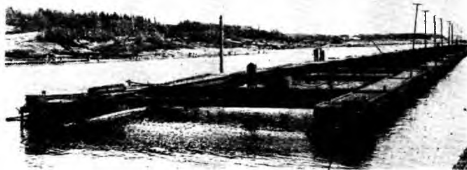
Рис. 4. Главный коридор сортировочной сетки на понтонах-катках (Керчевский рейд)
