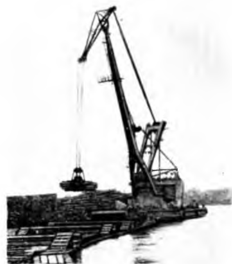
Рис. 2. Погрузка леса краном «Ганц» с использованием грейфера и устройства Р-4
