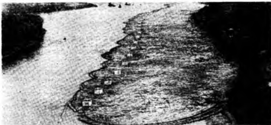
Рис. 2. Продольная запань с незасоренными выносами на р. Бие
