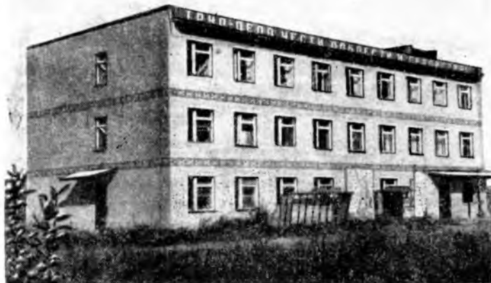
Административно-бытовое здание на нижнем складе в пос. Вохтога
