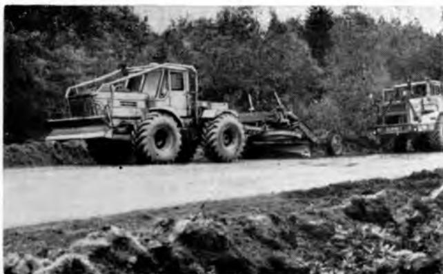
Профилировка дорожного полотна трактором ЛТ-157, оборудованным грейдерной и бульдозерной установками
