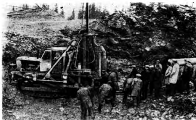
Полевые занятия в школе передового опыта у буровой установки БТС-150
