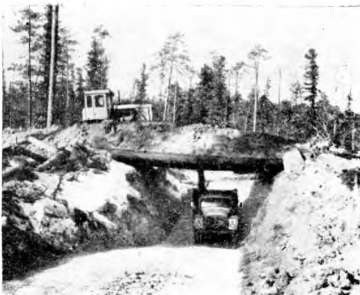
Загрузка самосвала грунтом с помощью бульдозера
