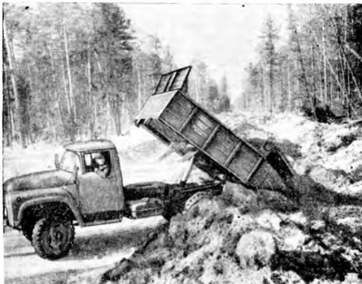
Отсыпка земляного полотна
