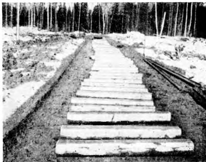
Укладка шпал на земляное полотно, отсыпанное зимой
