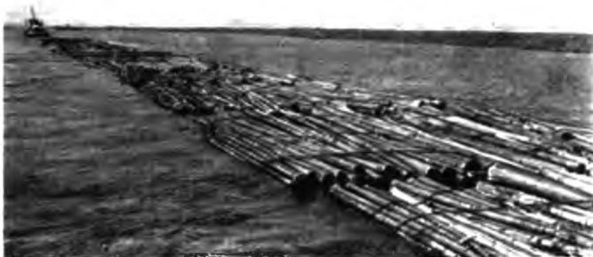
Рис. 1. Озерный хлыстовый плот усиленной конструкции перед выходом в Ладожское озеро
