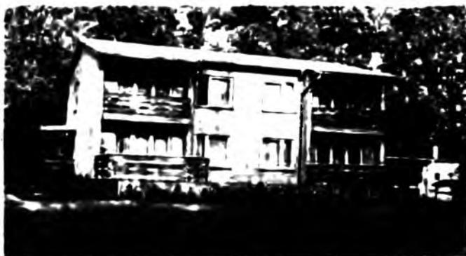
Рис. 1. Деревобетонный дом типа «Лапро»
